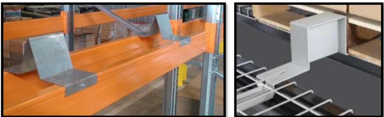
Rys. 2 - Przykłady ogranicznika stosowanego dla zagwarantowania minimalnego dystansu między paletami ze względu na wymagania dla ochrony tryskaczowej
